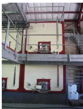
Cuve en béton tapissée de céramique
