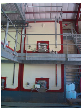
Cuve en béton tapissée de céramique
